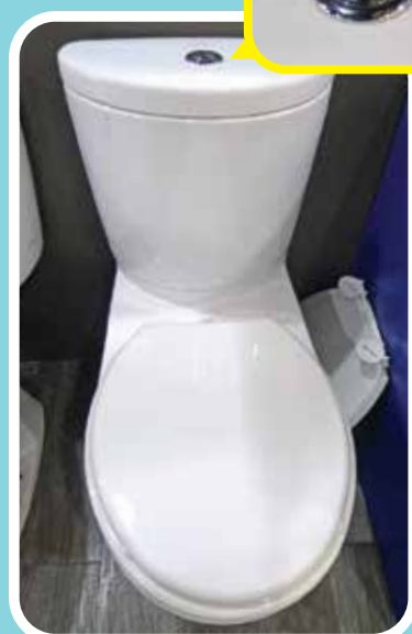
市場上4.5公升/ 3公升大小便分檔馬桶 Vaso sanitário com descarga dupla de 4,5 L/3 L comercializado no mercado
